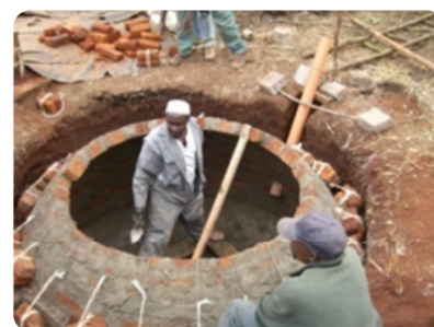
Bau von Biogasanlagen für Haushalte in Kenia
